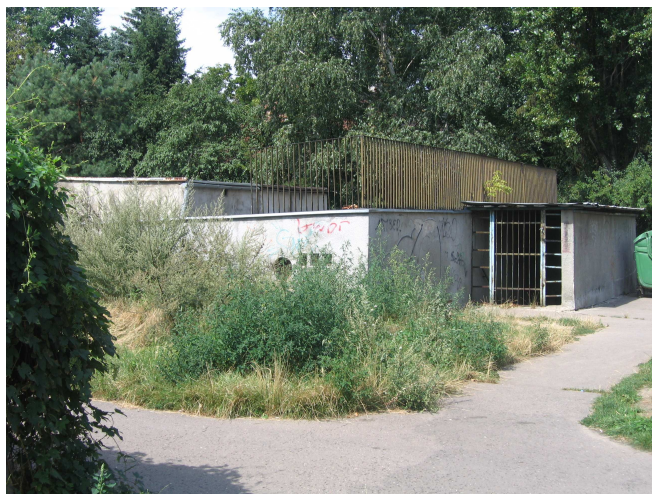
Hydrofornia przy ul. Zagranicznej 1
